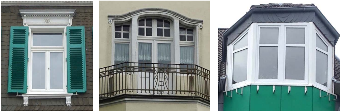
Abbildung 112: Verschiedene Fensterausführungen mit Oberlichtern
