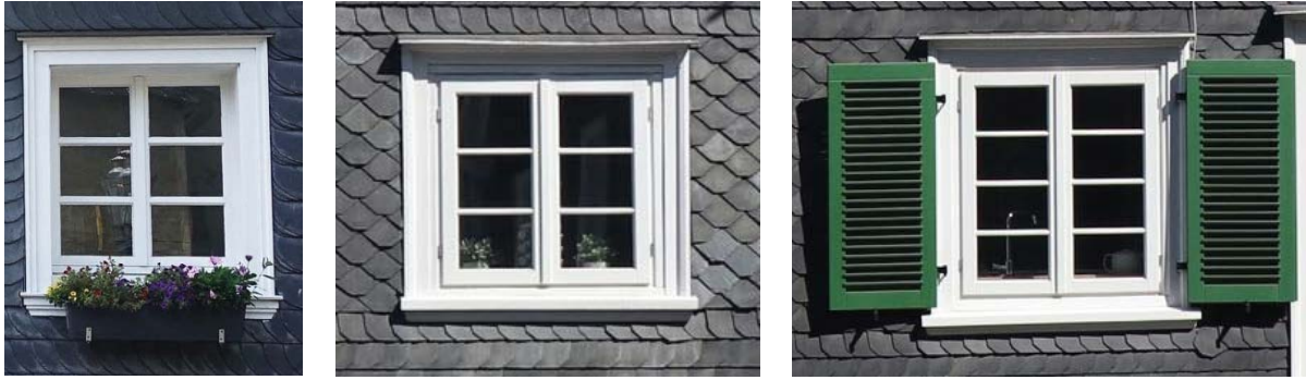
Abbildung 111: Sprossenfenster historischer Fachwerkbebauung
