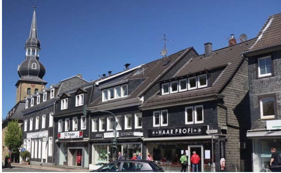
Abbildung 57: Bebauung westliche Hauptstraße
