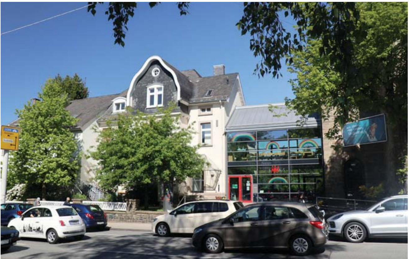
HAUPTSTRASSE 37A & 37B
