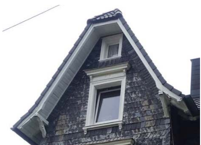
Abbildung 116: Attika- bzw. Ortgangvarianten
