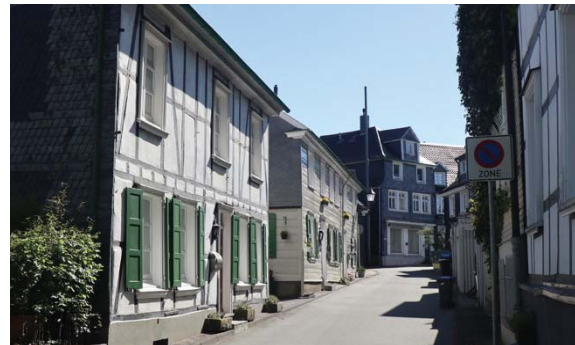
Abbildung 56: Straßenzug „An der Hütte“
