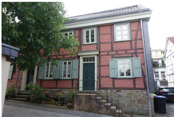
Abbildung 87: Bergisches Fachwerkhaus An der Hütte 6
