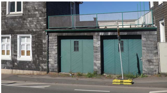
Abbildung 77: Nebengebäude Berghauser Straße 2
