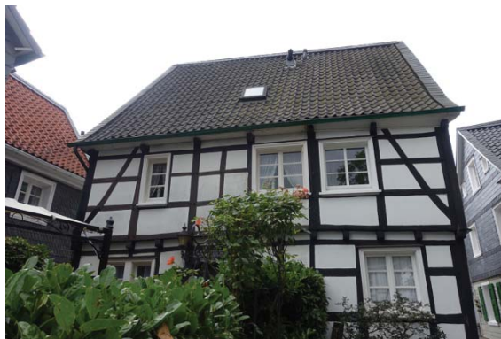
Abbildung 88: Bergisches Fachwerkhaus An der Hütte 10
