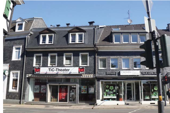
Abbildung 94: überformte Erdgeschosszone Hauptstraße 3, 5 (2020)
