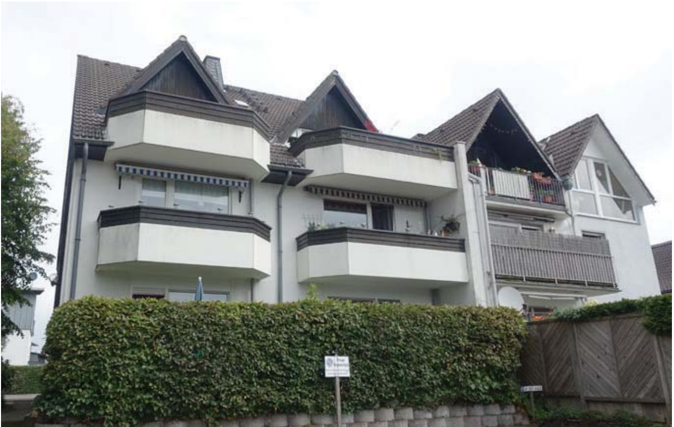
SOLINGERSTRASSE 15 & 17 (RÜCKSEITE, SCHORFERSTRASSE)
