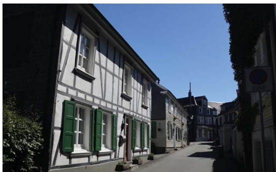
Abbildung 89: Bergisches Fachwerkhaus An der Hütte 15 1 und 3
