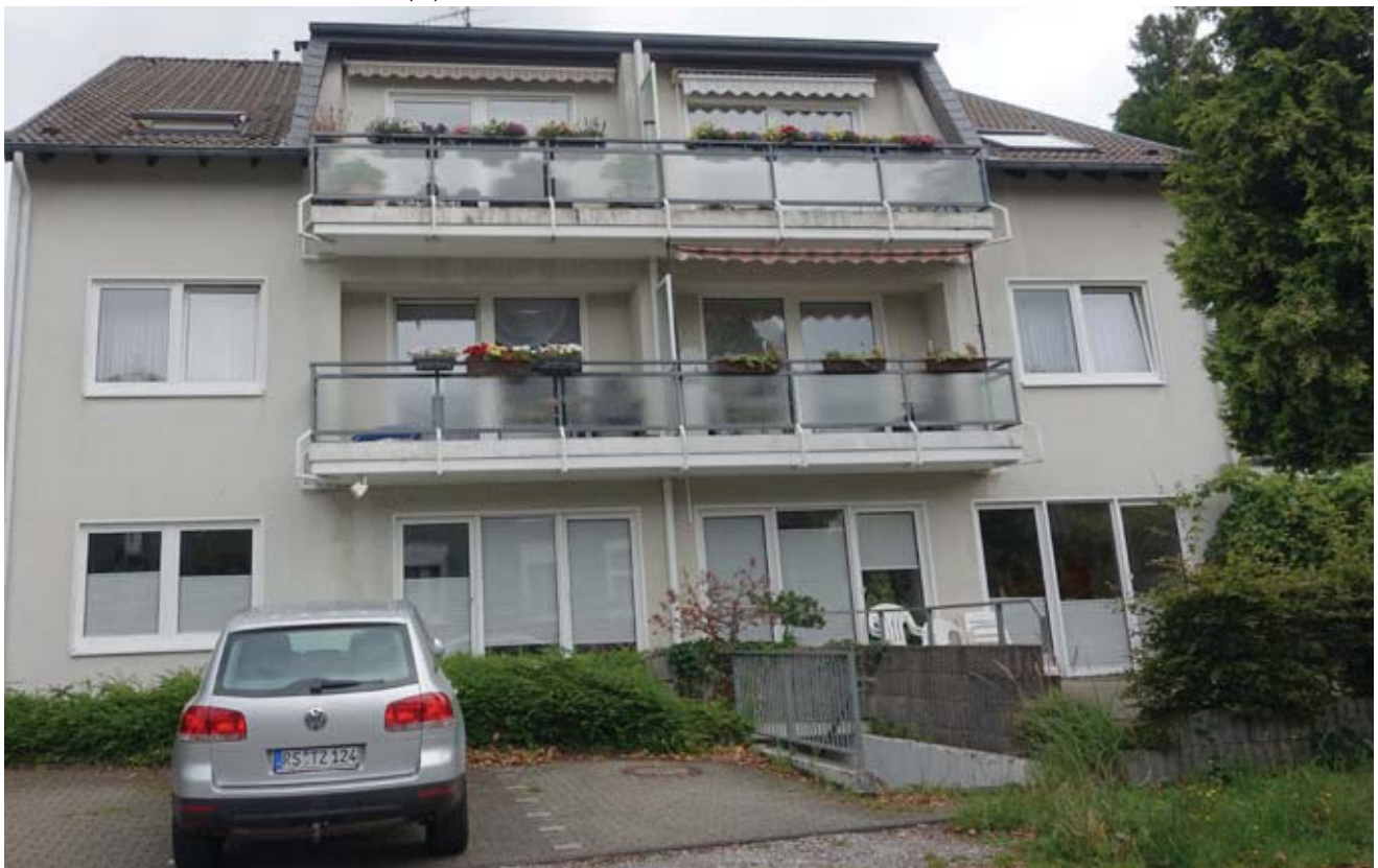
SOLINGER STRASSE 25 (RÜCKSEITE, SCHORFER STRASSE)
