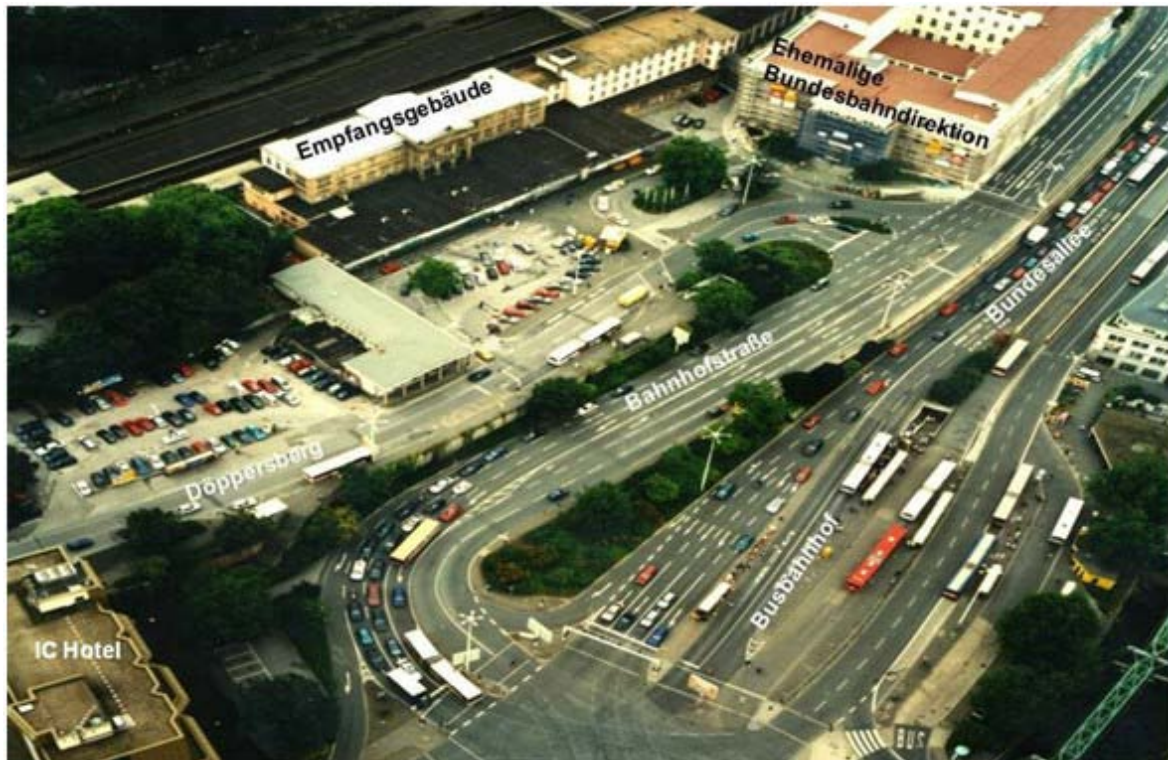
Abbildung 6: Der Döppersberg aus der Vogelperspektive vor Beginn der Baumaßnahmen (2004)
