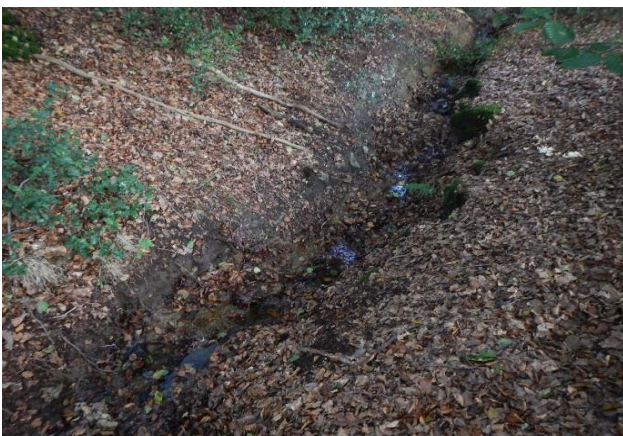
Foto 17: Wasserführung Erlenroder Siefen 3
