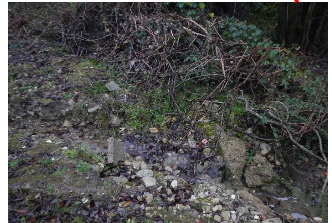
Meine - Bereich ehem. Einleitung RRB 2
