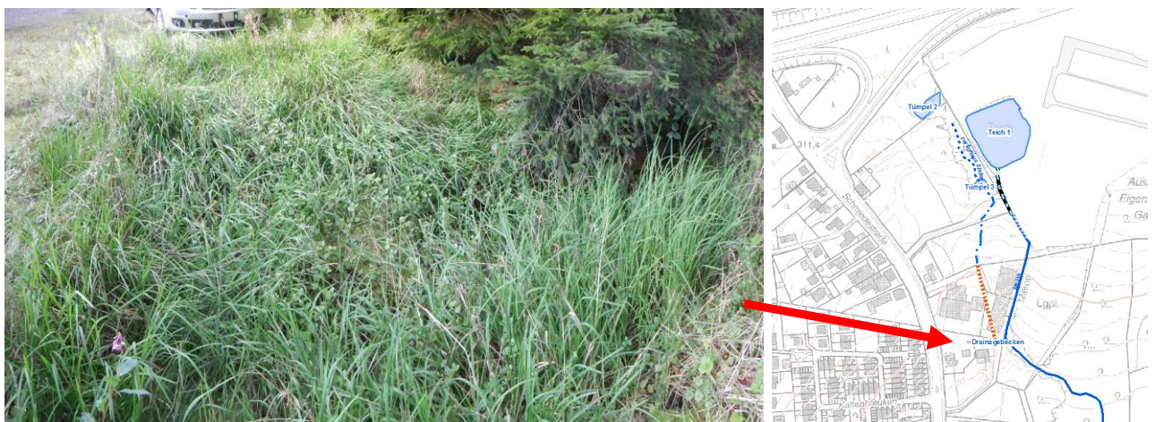
Abb. 14: Drainagebecken an der „ Meine “ – Begehung am 01.10.2014
