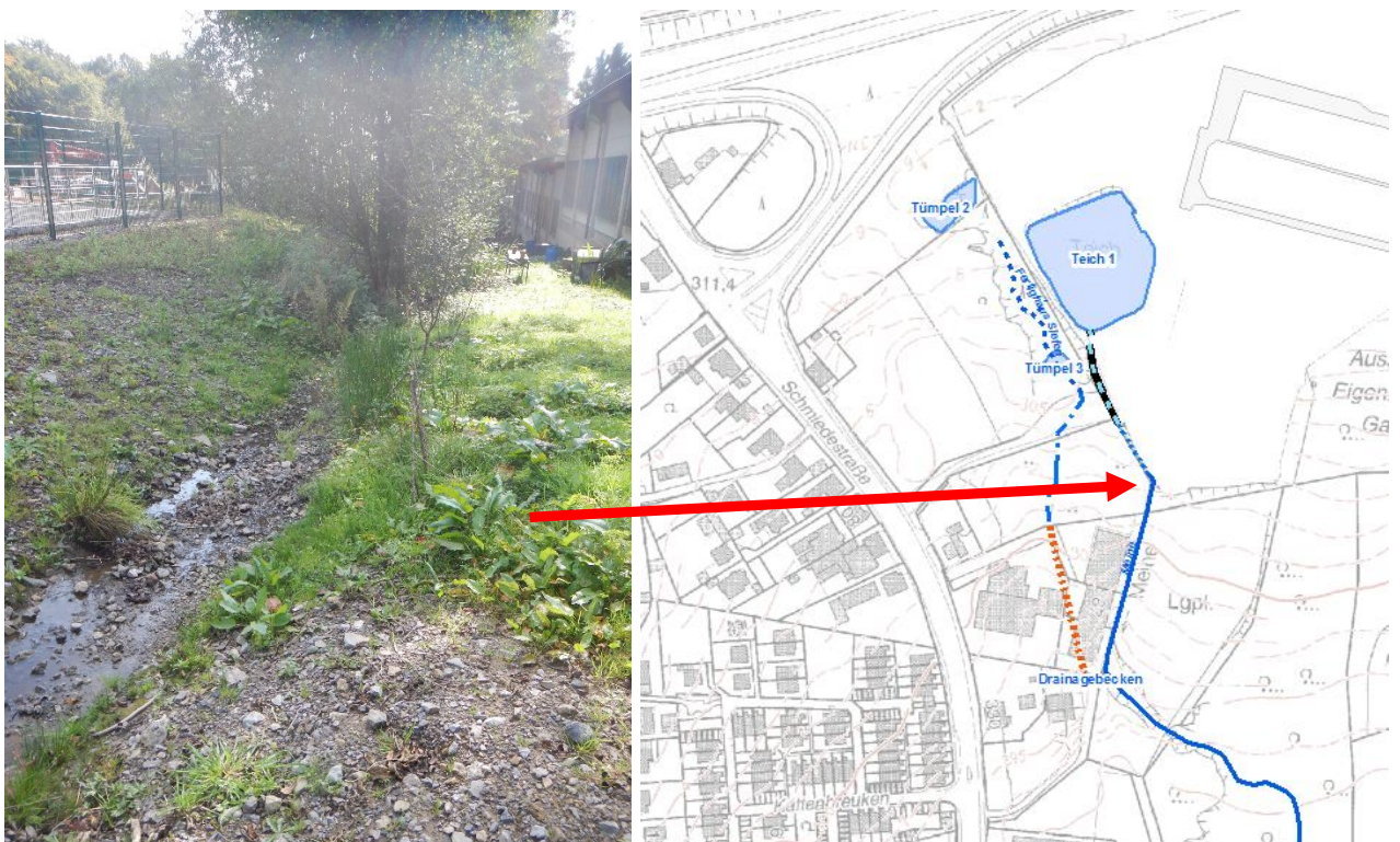
Abb. 13: Oberlauf der „Meine“ westlich des neuen RRB – Begehung am 01.10.2014
