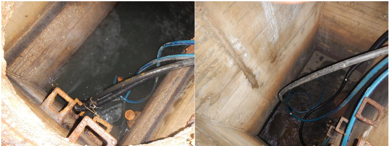
Abb. 4: Kontrolle Auslaufbauwerk „Teich 1“ am 10.12.2014 (links Einlaufkammer, rechts Auslaufkammer)
