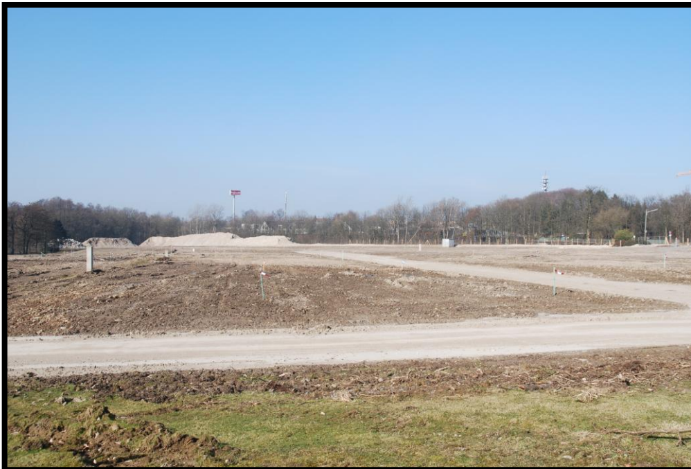
Darstellung: Gelände nach dem Rückbau – Blick vom Südost nach Nordwest. Aufnahmedatum März 2014 .
