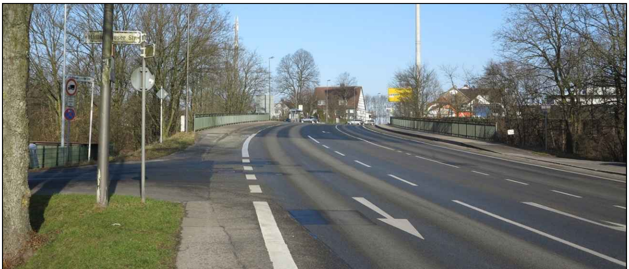
Abbildung 8: Schmiedestraße im Bereich der Brücke über die BAB 46, Blickrichtung Norden
