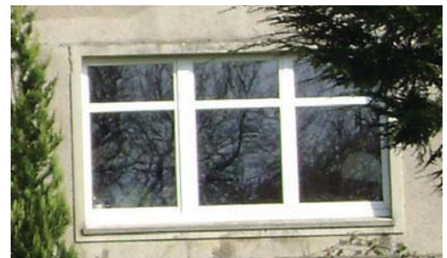
Walmdach mit Dachgaube Beispiele der ursprünglichen Fensteraufteilung,
