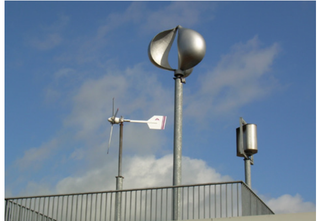
Mikro-Windenergieanlagen der Ökostation Bauen und Technik
