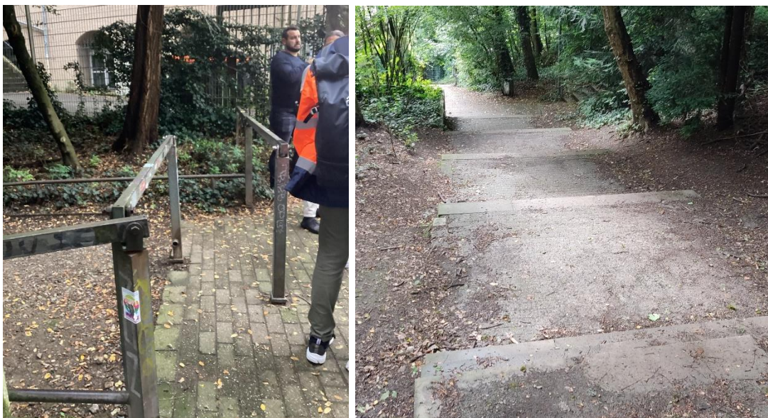
Abbildung 17: links nicht barrierefreie Umlaufsperrung und rechts fehlende Kennzeichnung der Stufen
