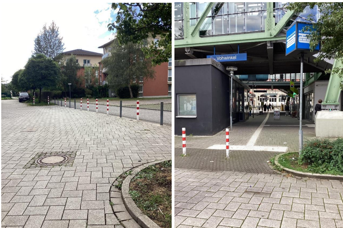
Abbildung 27 Radweg „Am Stationsgarten und Blindenleitsystem am Bahnhof der Schwebebahn
