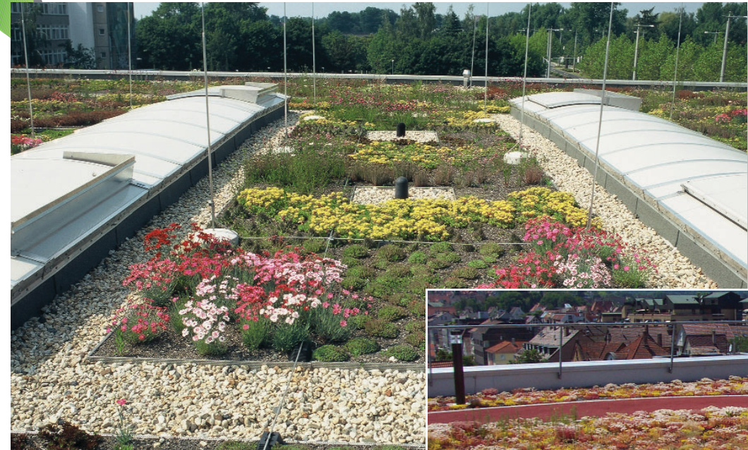
Gründach, bei dem die Vegetation vor einem Jahr gepflanzt wurde
