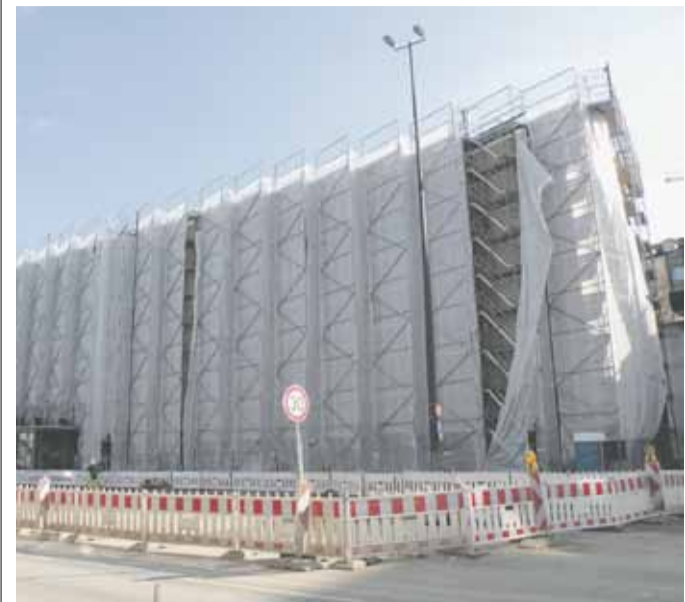
Das Berufskolleg Elberfeld während der Sanierung: fast schon ein Christo-Kunstwerk
