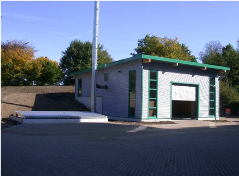
Kesselhaus der Holzhackschnitzelheizung und Ladeluke für den Hackschnitzelbunker (links).
