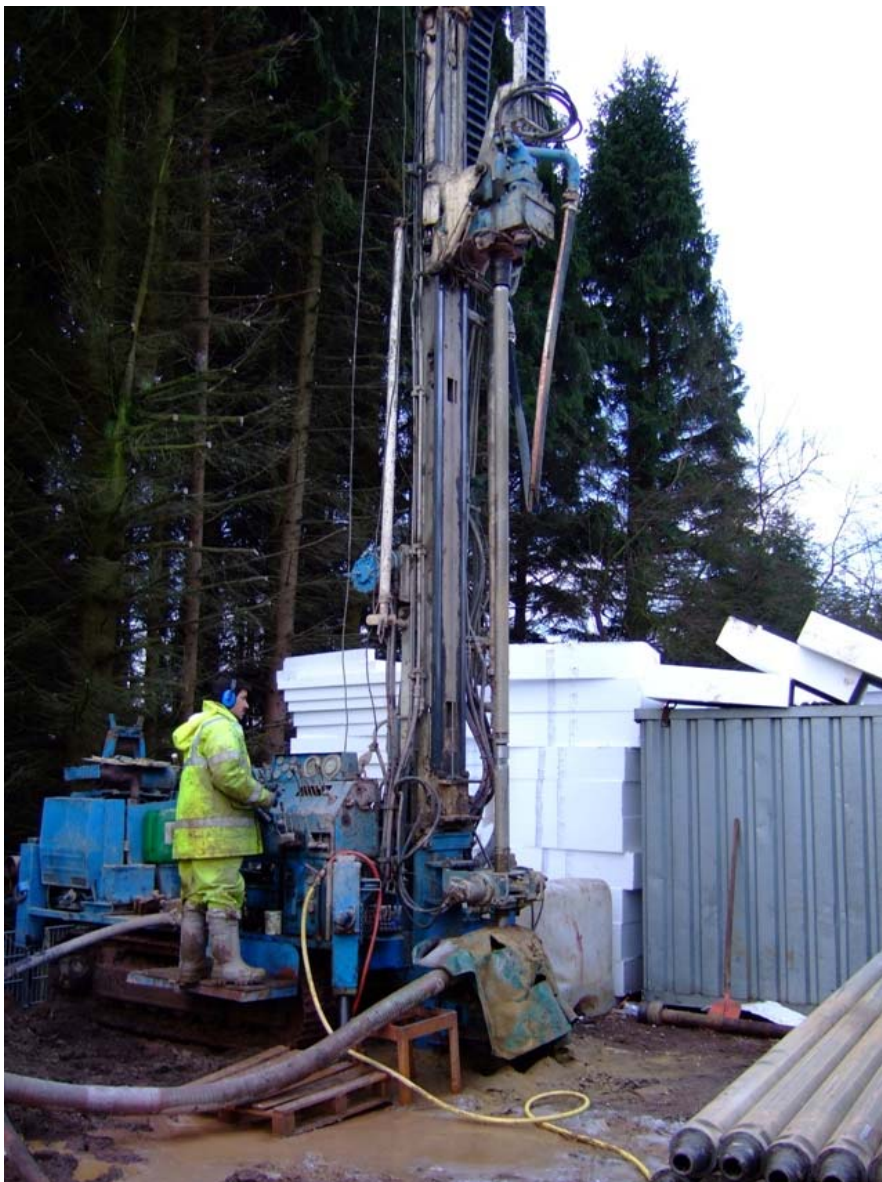
Durchführung der Bohrungen für die Erdwärmennutzung im Februar 2009 (Im Hintergrund Dämmmaterial)
