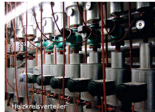
Heizkreisverteiler
