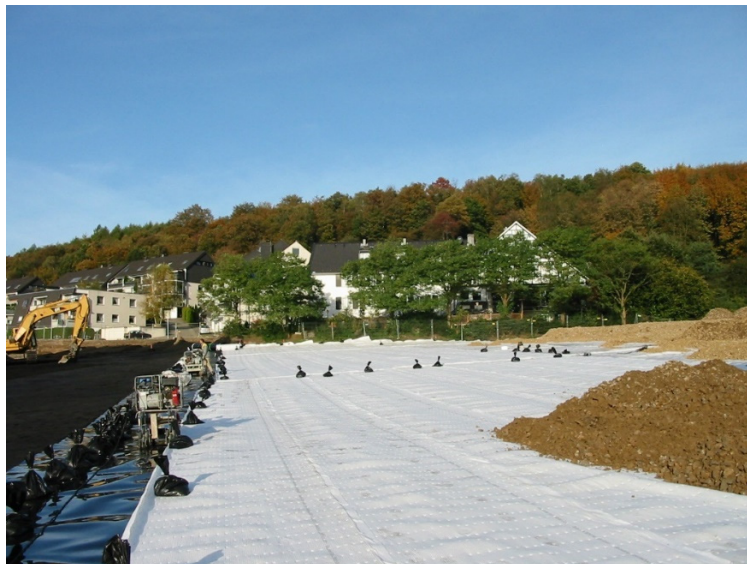
Abb. 1: Isolierung des Deponiekörpers mit einer Folie und Beginn der Abdeckung mit einer mageren Bodenschicht (2005, mit Genehmigung der Stadt Wuppertal).
