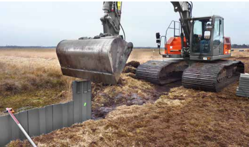
Abb. 3: Die Wiedervernässung von Mooren, beispielsweise durch den Einbau von Spundwänden wie hier im Oppenweher Moor (Kreis Minden-Lübbecke), ist eine wesentliche Maßnahme im Moorschutz. Foto: Thorsten Obracay
