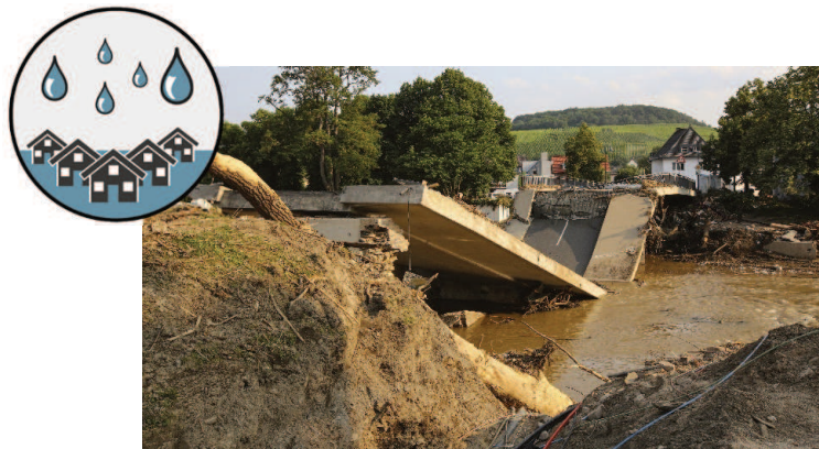
Zerstörte Brücke im Ahrtal. picture alliance/dpa / Bodo Marks
