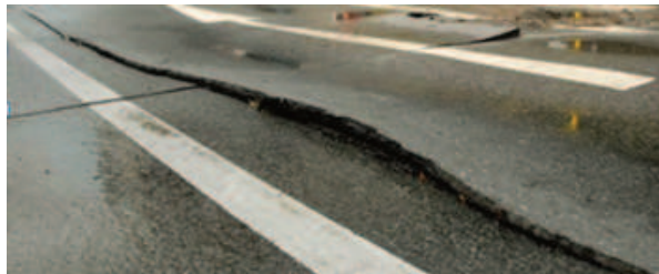
Überlauf des verrohrten Briller Bachs unter die Straßendecke nach Starkregen (2008)
