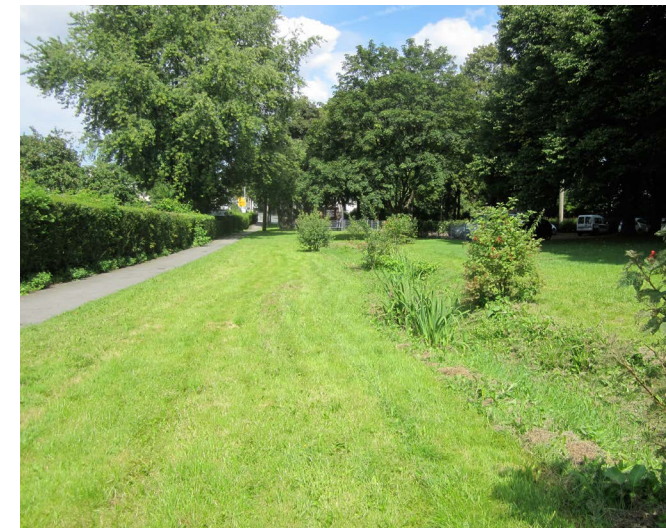
Entwässerungsmulde (Foto: © ISB)
