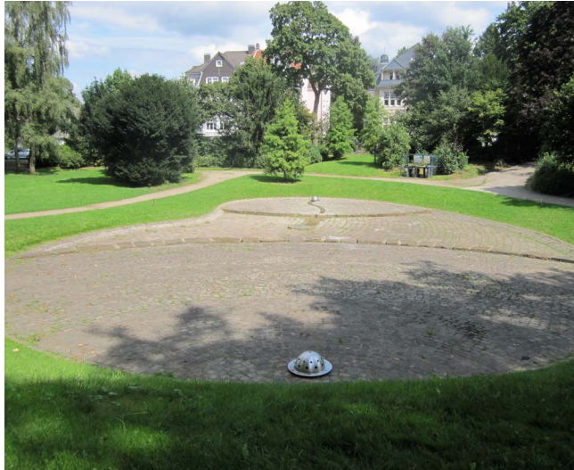
Retentionsfläche auf dem Bismarckplatz in Solingen (Foto: © ISB)
