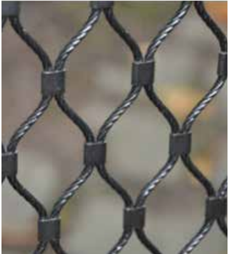
Das in Aralandia verwendete Edelstahlnetz hat eine Drahtstärke von 2.5 mm und eine Maschenweite von 3 cm Foto: Der Grüne Zoo Wuppertal
