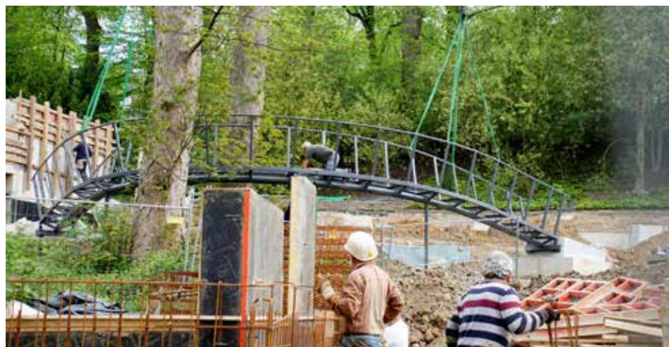
Montage der Abenteuerbrücke
