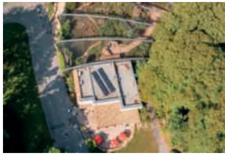
Vorbild Aralandia: Photovoltaikanlage auf dem Dach des Besucherzentrums Foto: Peter Frese
