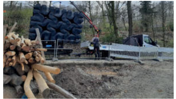
Einbau der Regenwasserzisterne
