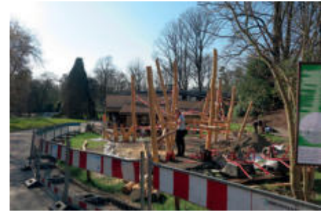
Bauarbeiten für den neuen Kletterspielplatz oberhalb von Aralandia Foto: Maria Spätling
