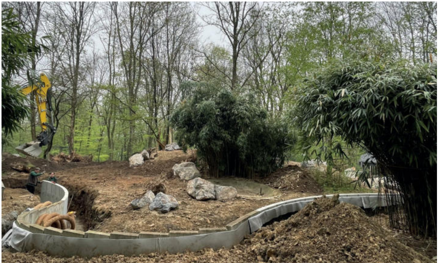
Die neue Anlage für die Roten Pandas im Bau
