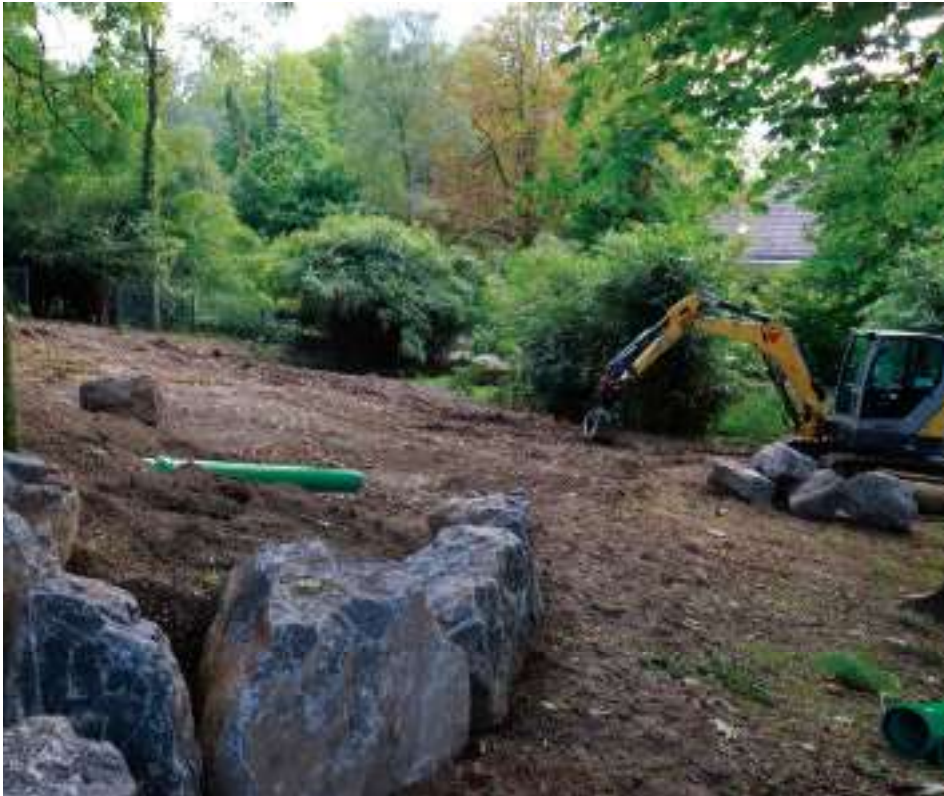
Baubeginn der neuen Anlage „Rivers of Sulawesi“ für Hirscheber und Kurzkrallenotter
