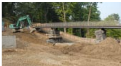
Baustelle an der Sambatrasse Foto: Birgit Klee
