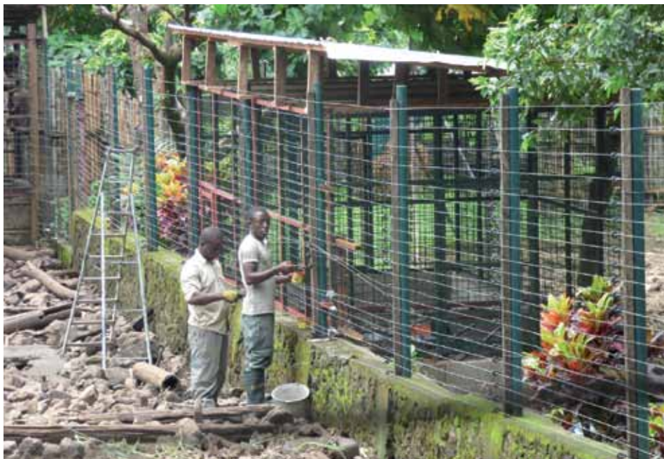
Bau neuer Absperrgehege für die Drills im Limbe Wildlife
