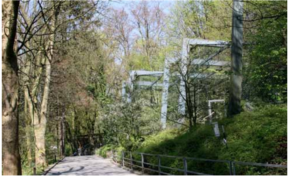
Die alten Greifvogelvolieren werden zur neuen Schneeleopardenanlage umgebaut
