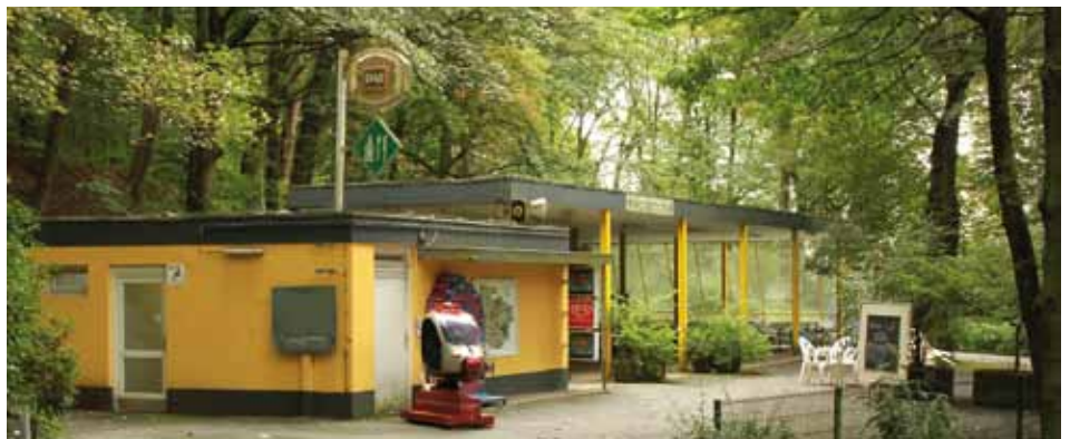
Die Waldschänke soll durch einen Neubau ersetzt werden
