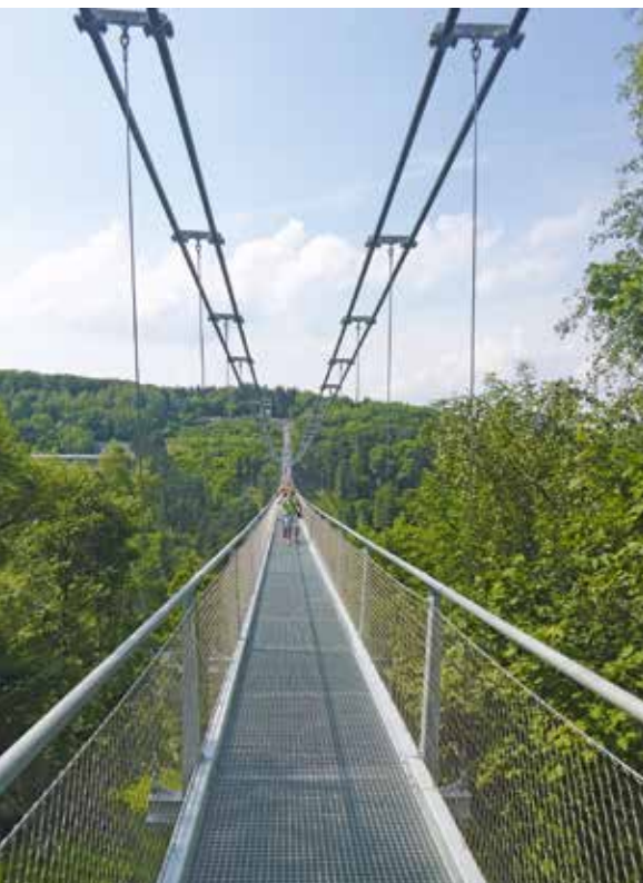
01 Hängebrücke als zentrales Element der BUGA, Quelle: Firma hochkant GmbH
