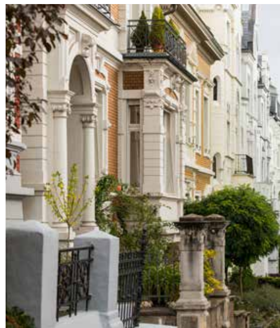
02 Gründerzeitbauten in der Elberfelder Nordstadt, Quelle: Stadtmarketing Wuppertal, Foto: Malte Reiter
