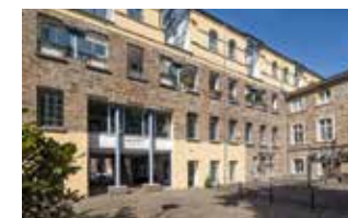
In dem ehemaligen Gebäude der Fabrik Ermen & Engels befindet sich heute das LVR-Industriemuseum
