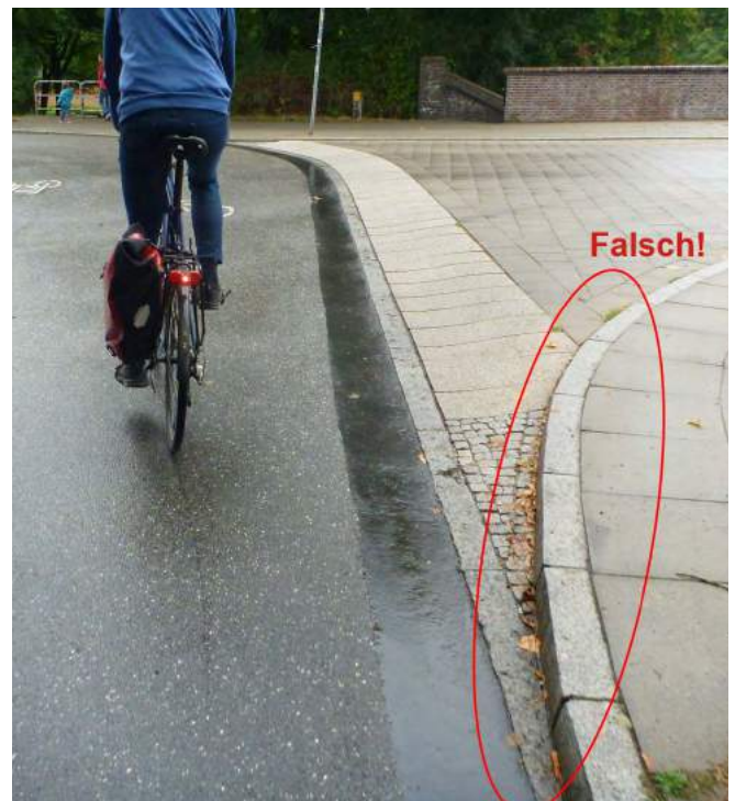
Abbildung 23: Falsche Ausbildung einer Gehwegüberfahrt, ebenfalls Hamburg. Der Bordstein folgt der einmündenden Straße (Uferstraße/Von-Essen-Straße).
