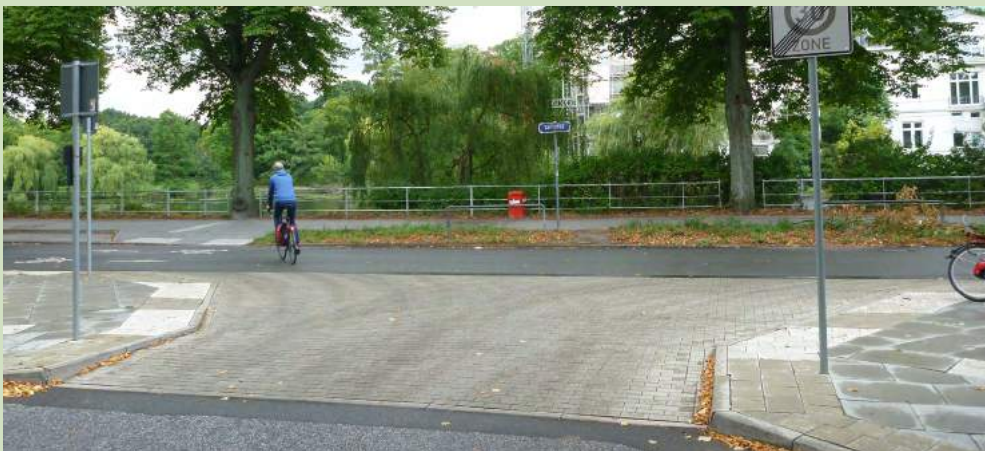
Abbildung 29: Gehwegüberfahrt am Leinpfad in Hamburg.
