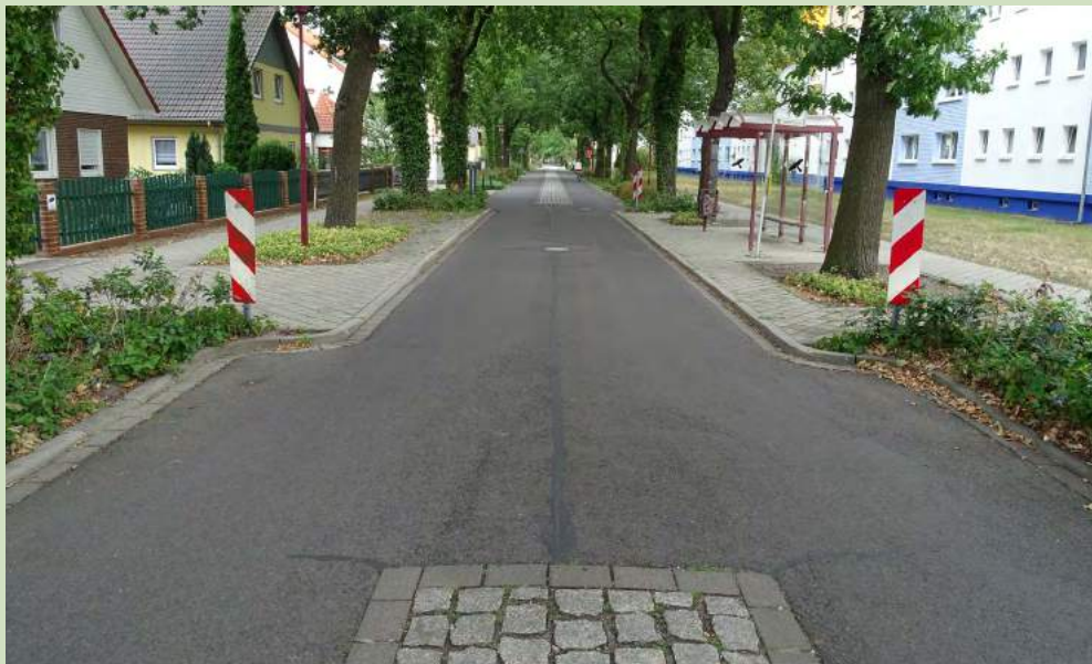
Abbildung 40: Haltestellenkap im Bereich der Bushaltestelle. Der gepflasterte Mittelstreifen ist hier unterbrochen (Ernst-Thälmann-Straße).
