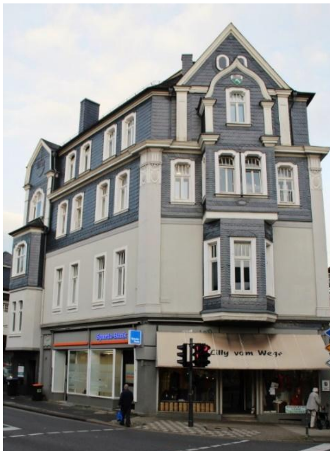
Abbildung 14: Denkmalgeschütztes Gebäude an der Bahnstr. 2
