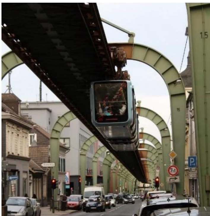
Abbildung 3: Bildung einer horizontalen Raumkante durch die Schwebebahn
