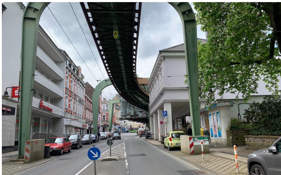
Abbildung 4: Schwebebahndaltestelle in der Blickachse der Vohwinkeler Straße
