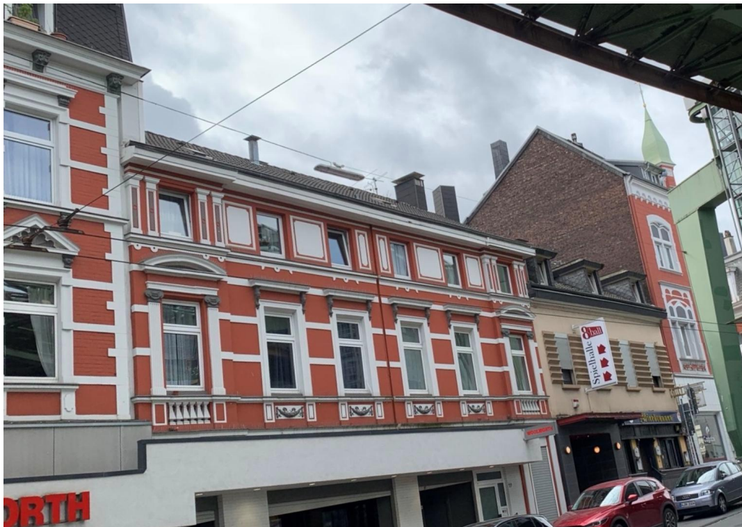
Abbildung 5: Höhenversprünge zwischen Gebäuden verschiedener Epochen
