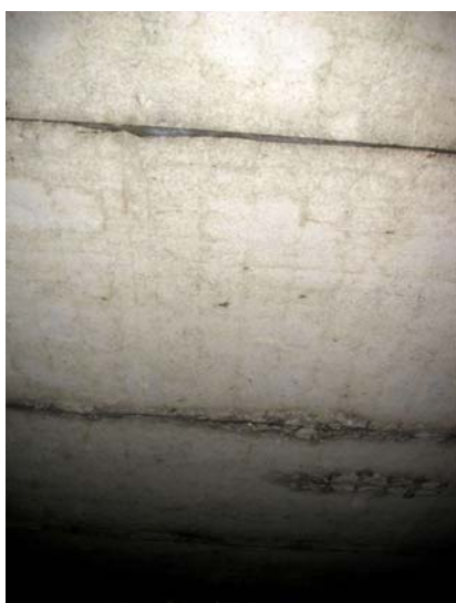
Foto 11: Dehnungsfugen in der Decke des Flutgrabens
