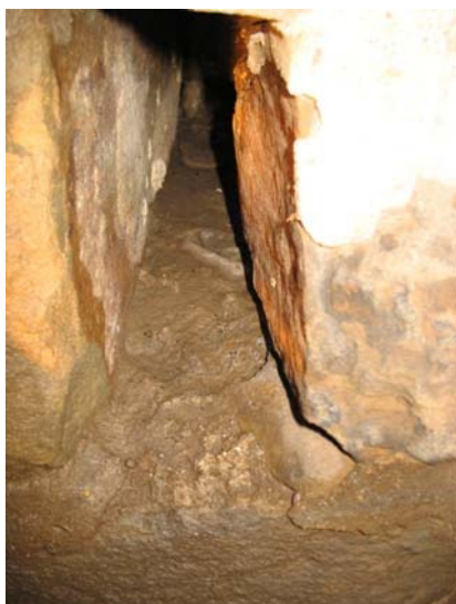
Foto 9: Spalte in Seitenwand
