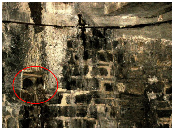
Foto 7: Einflussöffnung für Abwasser in Seitenwand des Flutgrabens
