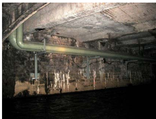
Foto 6: gemauerte Wand in Flutgraben
