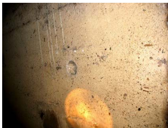
Foto 4: Seitenwand mit Betonplatten
