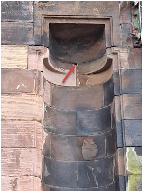
Abbildung 6: Links: Fugenlücken in der Stützmauer zur Straße Distelbeck (Stand 07.10.2024).
