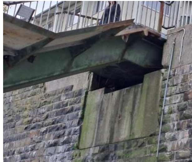
Abbildung 12: Widerlager der rückzubauenden PÜ an der Stützmauer. Blick vom Mittelbahnsteig 3 (Stand 07.10.2024).
